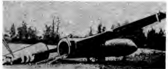
Rys. 19. Odrzucony tył szybowca Horsa dla ułatwienia szybkiego opuszczenia kabiny
