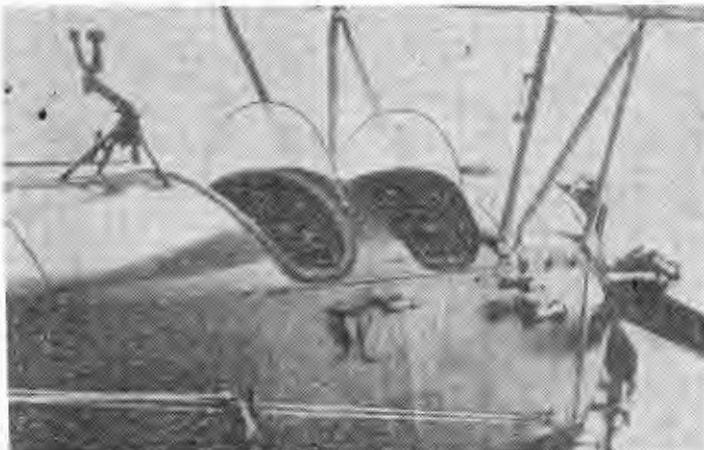
Rys. 2. Zabudowa k.m. i celownik bombowy na CSS-13. Fot. ILOT.
