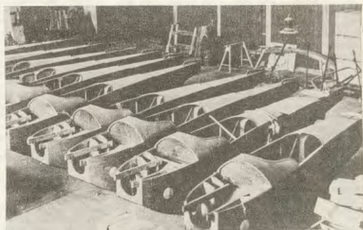
Rys. 13. Budowane seryjnie kadłuby samolotów KW-2 miały konstrukcję ramową opracowaną przez braci Florjańskich. W głębi kadłuba, za kabiną, widoczne wzmocnione wręgi
