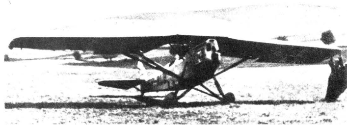
SP-ALB z silnikiem z cylindrami stojącymi i zwężonymi końcami skrzydeł z lotkami Frise ● SP-ALB with V-type engine, narrow wing tips and Frise ailerons
