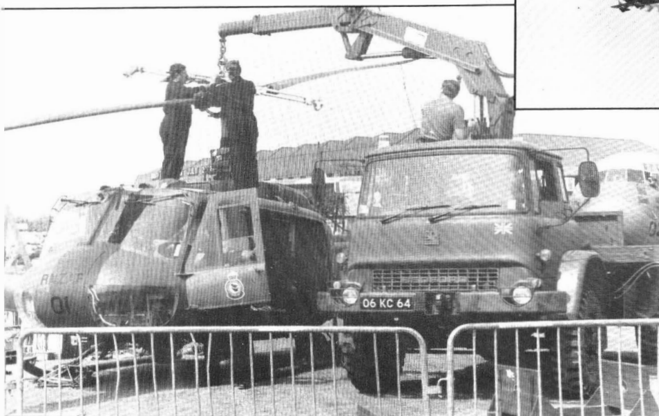
— Co oni robią z moim wirnikiem? I jak ja teraz polecę?! (UH-1H Iroquois z 3 dywizjonu Royal New Zealand Air Force demontowany do transportu w ładowni C-130H Herculesa, widocznego w tle)
