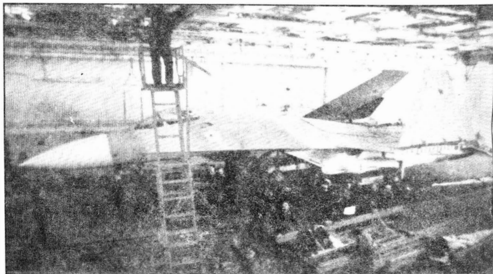
Makieta pokładowego Su-27 zbudowana specjalnie do prób hangarowania pod pokładem „Tbilisi”
