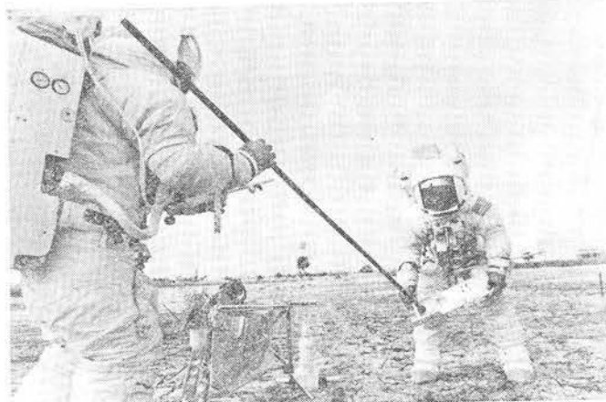
6. F. Haise (z lewej) i J. Lovell na poligonie w Houston montują wiertło, za pomocą którego mieli oni wywiercić na Księżycu otwór o głębokości 3 m, aby umieścić w nim czujniki do pomiaru przepływu ciepła
