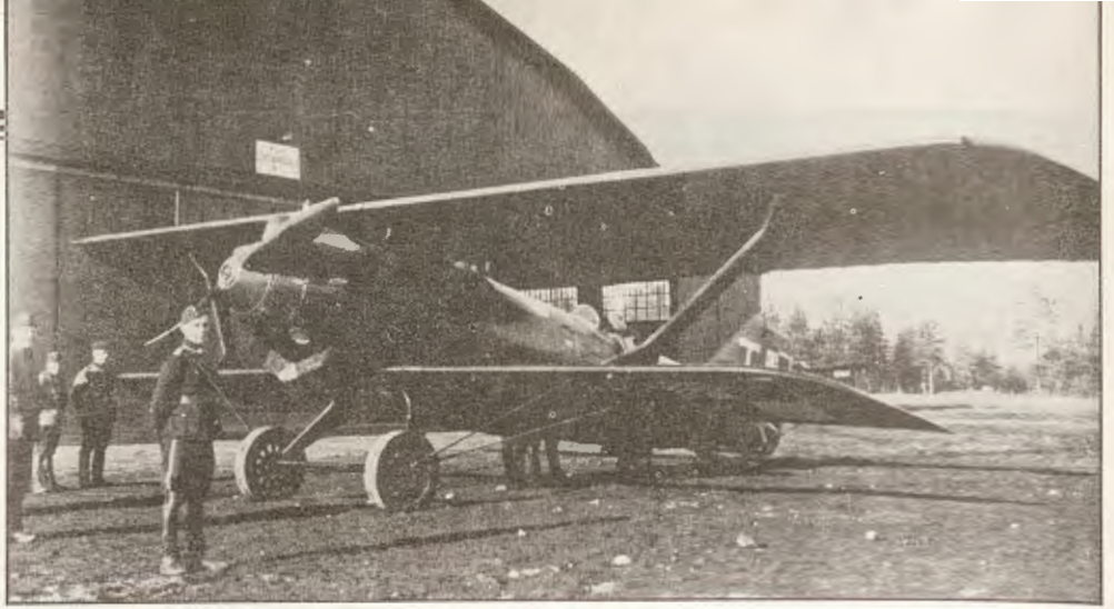
Breguet XIX B2 z zabudowaną na czas rajdu kabiną pilota, która została przeniesiona do stanowiska strzelca
