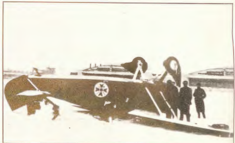
W listopadzie 1936 r., podczas prób fabrycznych samolotu myśliwskiego PZL P. 24B dla Bulgarii, Jerzy Widawski skapotał na lotnisku Okęcie – z powodu zamarznięcia śniegu w owiewce koła Ze zbiorów R. Kaczkowskiego, reprod. A. Glass
