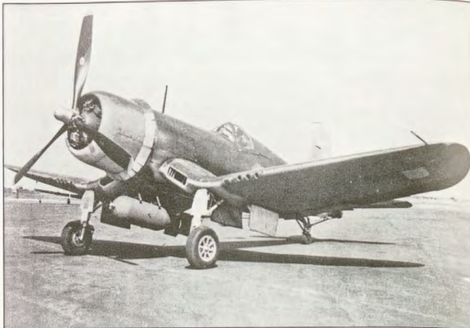
F4U-1A s/n 18026 z podkadłubowym wyrzutnikiem bomb firmy Brewster i bombą 454 kg (1000 funtów), sfotografowany 8 stycznia 1945 r.
