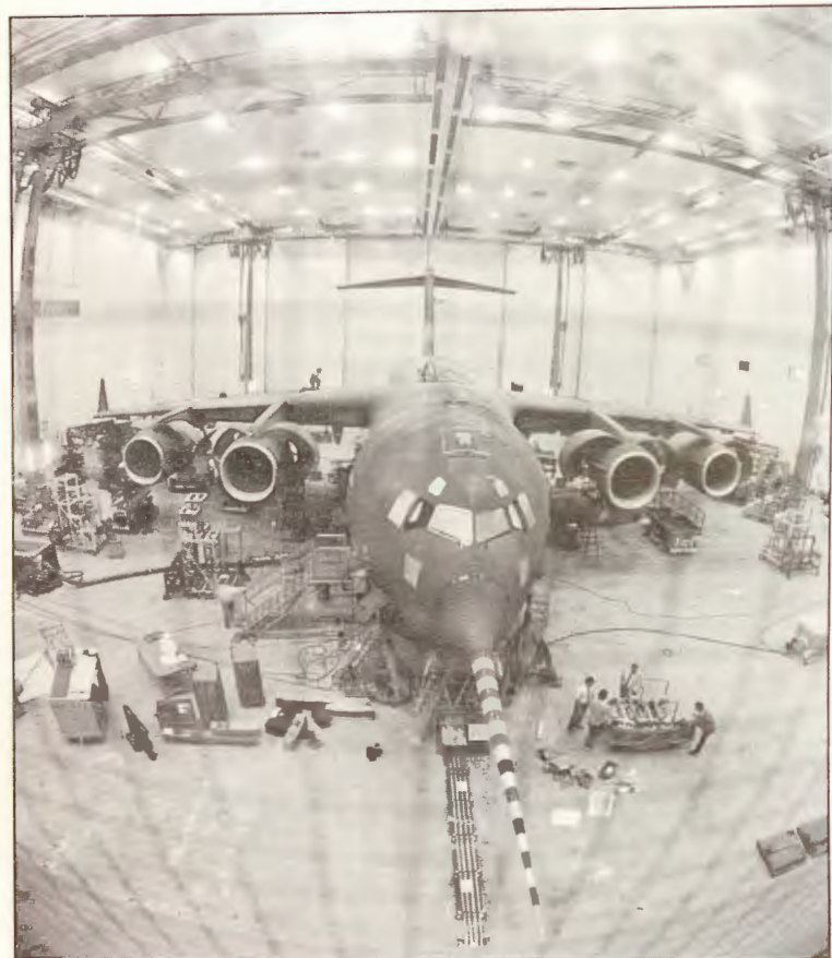
Prototyp samolotu transportowego McDonnell Douglas C-17, jest w hali montażowej. Jest to zdjęcie już archiwalne, bowiem prototyp oblatano 15 września 1991 r.; po zakończeniu prób łączną liczbą 5 samolotów prototypowych, kilka egzemplarzy seryjnych dostarczono już do US Air Force. Prototyp wyróżnia się m. in. sondą widoczną na pierwszym planie
