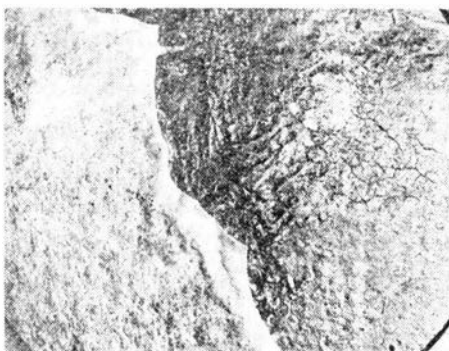
Rys. 2. Miejscowe wystąpienie siatki starzeniowej na powierzchni zewnętrznej zbiornika paliwowego; starzenie ozonowo-tlenowe. Siatka pęknięć powstała w miejscu uszkodzenia powłoki ochronnej — tzw. warstwy antyozonowej
