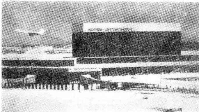
Rys. 11. Dworzec Szeremietiewo-2 od strony drogi podjazdowej
