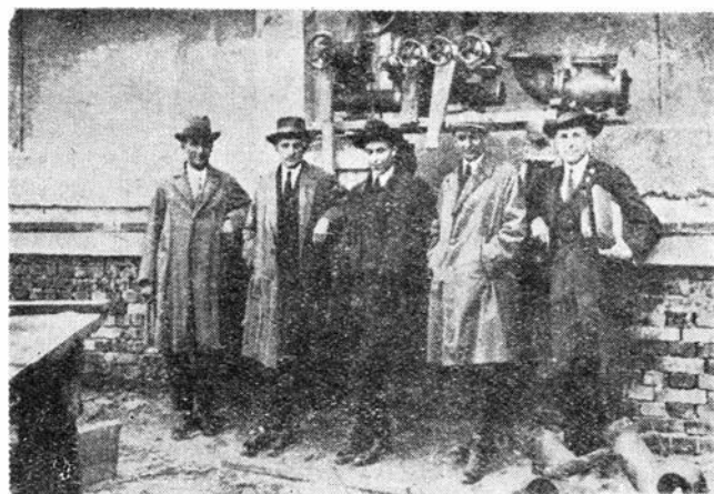
4. Na budowie instalacji benzynowni w Dęblinie stoją od prawej: inż. B. Kowalski, inż. K. Szymański, inż. S. Hojarczyk, inż. S. Jaroszewski i inż. M. Bajewski. Rok 1927. Ze zbiorów autora (niepublikowane)
