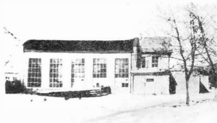
12. Pozostałość dzisiejsza po elektrowni z roku 1927 na jednym z lotnisk wojskowych — ze zbiorów autora (niepublikowane)
