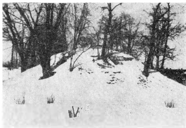
5. Resztki dużego magazynu podziemnego przy przejeździe kolejowym w Dęblinie, wysadzonego przez Niemców w powietrze. Na zdjęciu jeden z ocalałych zbiorników stojących w żelbetowej obudowie przysypanej ziemią. Stąd paliwo przesyłano na lotnisko rurociągiem — ze zbiorów autora (niepublikowane) obecnie teren miejski
