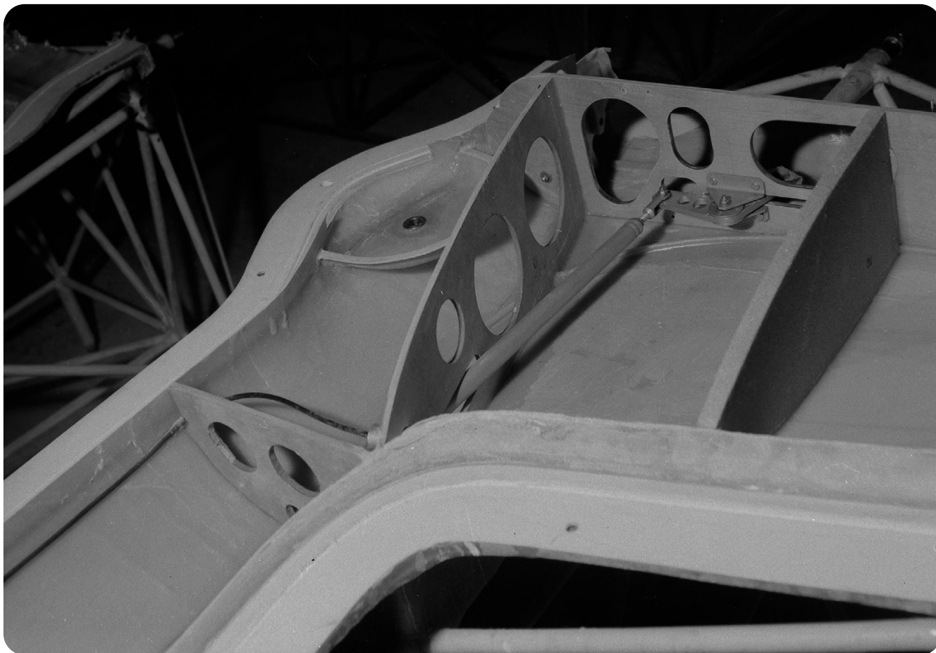
Ryc. 14. Tył kadłuba w budowie – widoczne żebra statecznika kierunku, napędy sterów Źródło: Archiwum SZD
