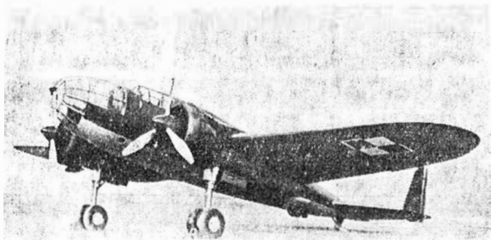
Rys. 5. PZL-37A bis z silnikami Pegasus XII i z podwójnym usterzeniem
