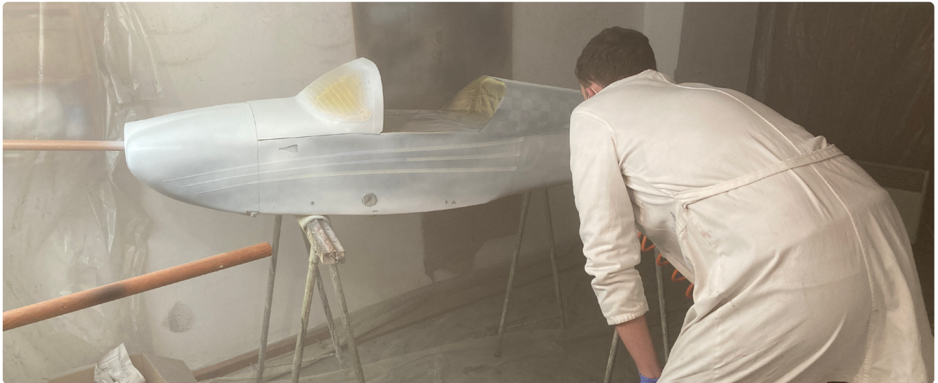
Ryc. 33. Nakładanie warstwy podkładowej w garażu
