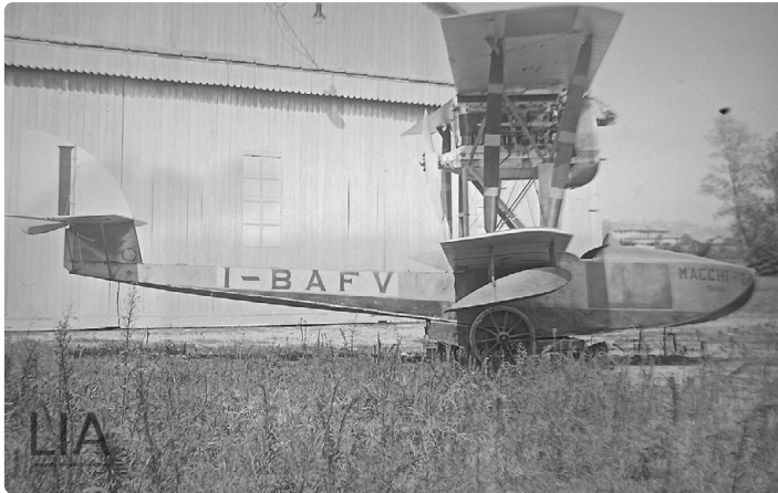
Ryc. 14. Zwycięski samolot M.7 bis G. De Brigantiego rej. I-BAFV. Na drugiej fotografii ten sam samolot w reklamie olejów firmy Mobil. Dobrze widoczna zmieniona chłodnica w porównaniu do modelu M.7
