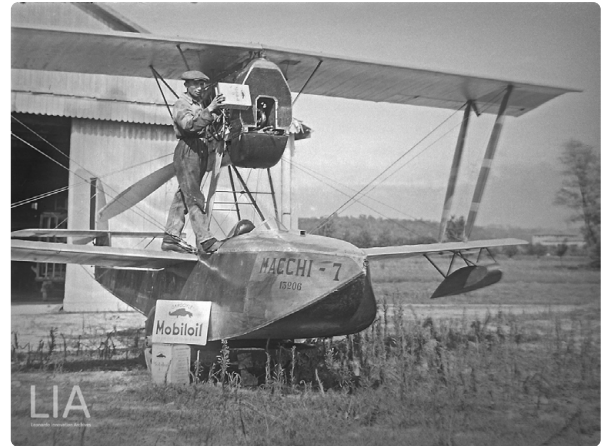
Ryc. 14. Zwycięski samolot M.7 bis G. De Brigantiego rej. I-BAFV. Na drugiej fotografii ten sam samolot w reklamie olejów firmy Mobil. Dobrze widoczna zmieniona chłodnica w porównaniu do modelu M.7
