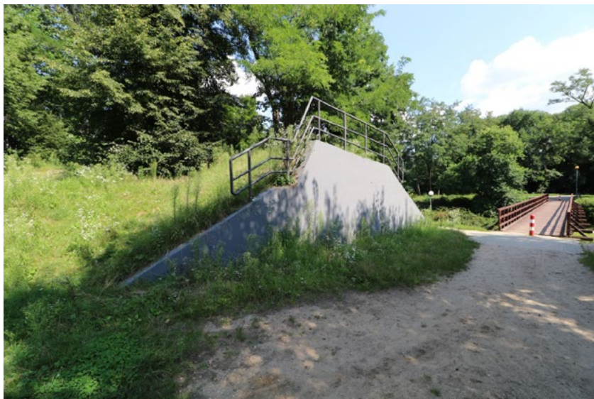
Ryc. 6. System ciągów komunikacyjnych oraz dydaktyczny przekrój przez strukturę wału ziemnego – zdjęcie Piotr Gleń, sierpień 2021
